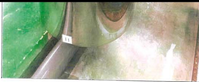
バグフィルタ下部およびボット外観を撮影。
