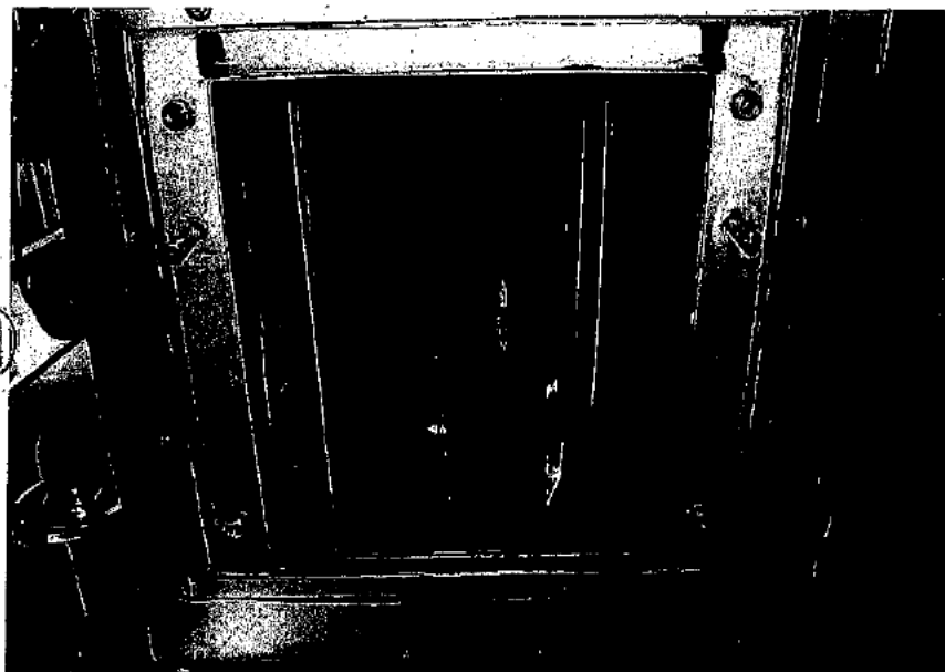
乾熱運転を終了後、バグフィルタ側面のプレートを取り外し、ろ布の状況を撮影 開始前と終了後のろ布に変化はなかった
