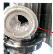
⑪測定口の内部 変色なし
