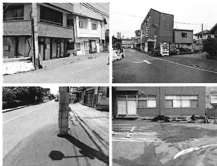
図 24 熊本市南区近見から元三町「液状化の帯」における液状化構造物被害
