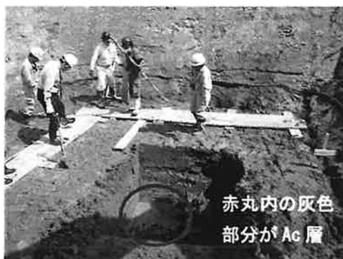
写真11 掘削後のトレンチの状況
