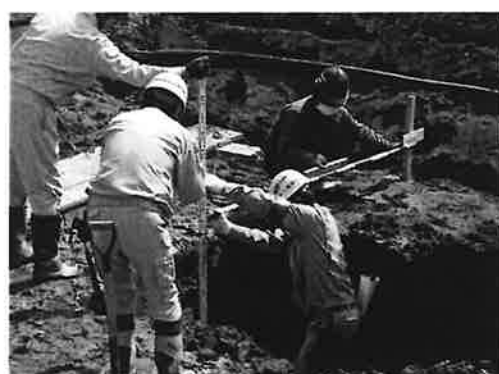
写真10 As層厚の確認状況
