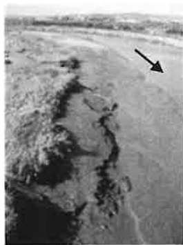
写真3 低水路河岸状況（主流部付近）
