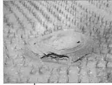
漏水状況（噴砂口）
