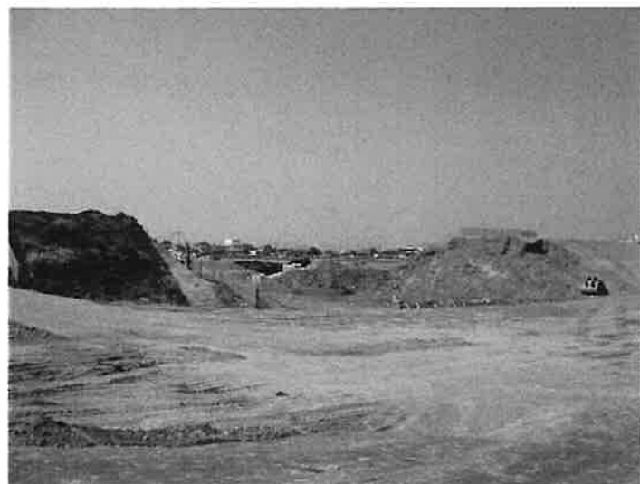
写真2 現地の状況（堤外地側から撮影）
