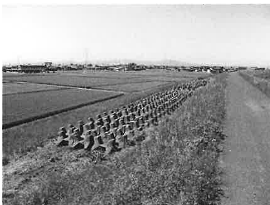
写真 6.1.3 根固ブロックの備蓄（矢部川右岸 9k600）
