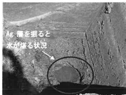
写真 19 Ac層とAg層の状況 (Ag層の地下水は不圧状態)
