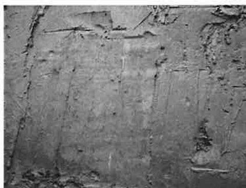
写真5 堤体開削断面の表面
