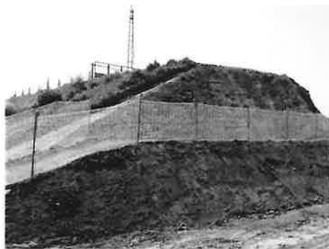
写真3 下流側の堤体開削断面
