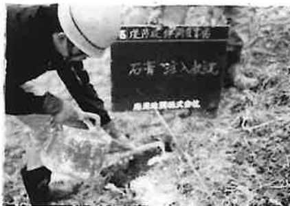
モグラ穴への石膏注入状況
