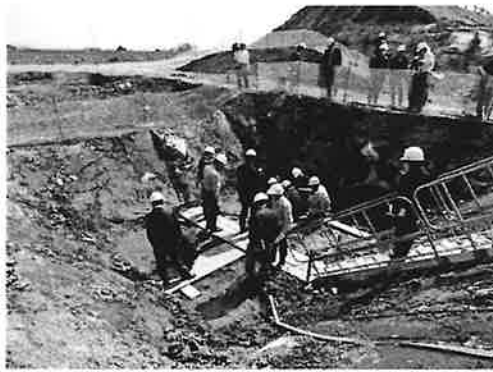
写真 13 決壊箇所の基礎地盤調査状況
