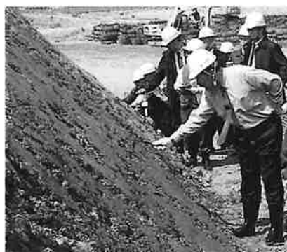
写真4 堤体開削断面の状況
