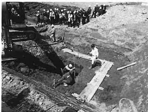
写真9 As層下のAc層を確認
