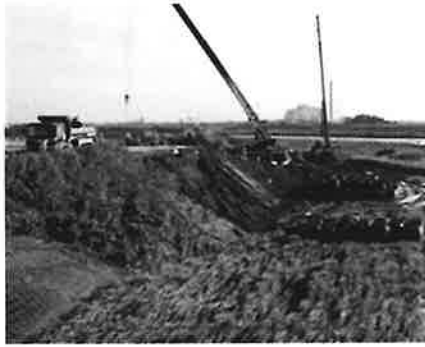
写真1 24年7月15日右岸7.3k付近河道状況 ※植生の侵食・裸地化はみられない
