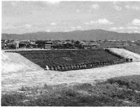
写真 6.2.1 緊急復旧完了状況
