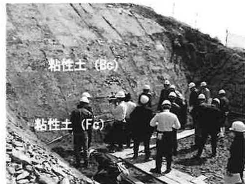
写真8 砂層(As層)と粘性土の確認状況
