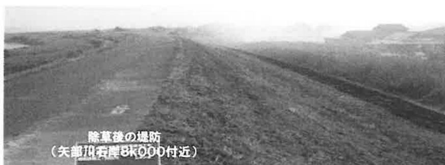
写真 6.1.1 堤防除草の状況
