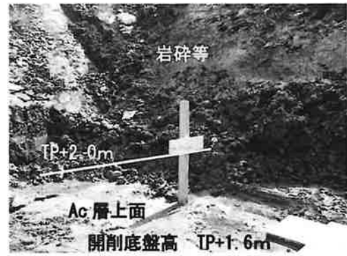
写真 14 Ac層と岩砕等による盛土の状況
