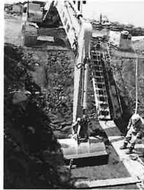
写真 15 Ac層の掘削状況
