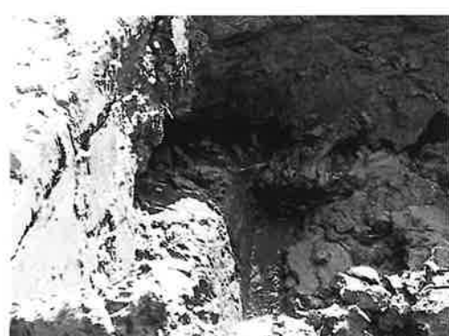
写真12 Asからの不圧地下水の浸み出しと砂の粒子の流失状況
