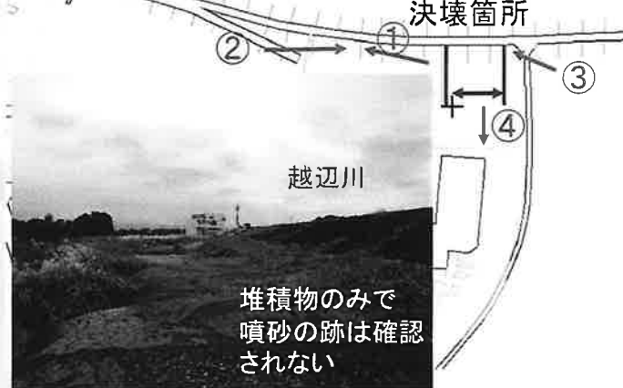
②決壊箇所周辺では、噴砂等は確認されていない。
