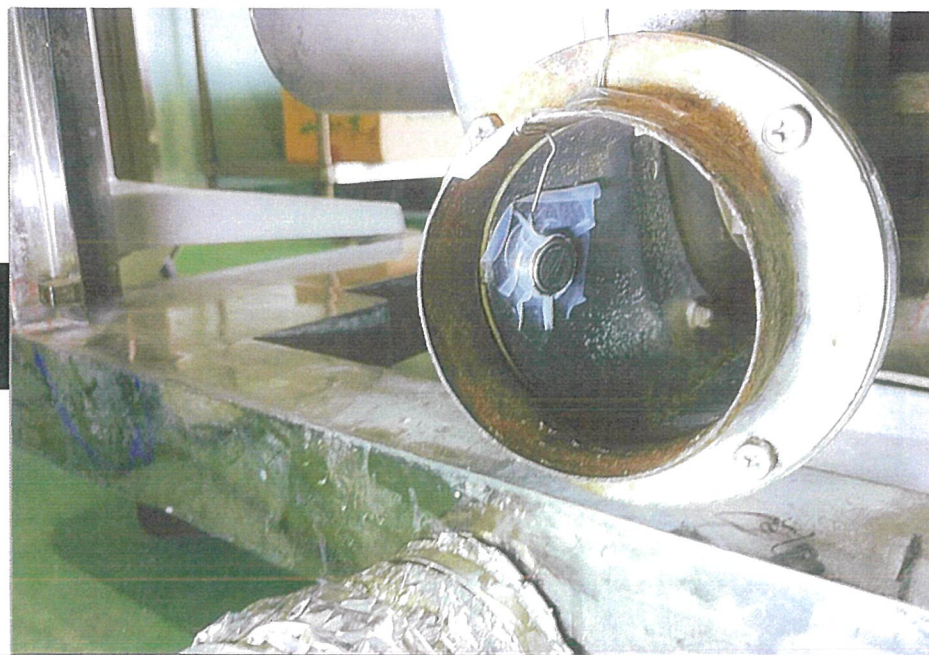
排風機後ダクト内に極細型熱電対を挿入した様子及び測定箇所Fを撮影。
