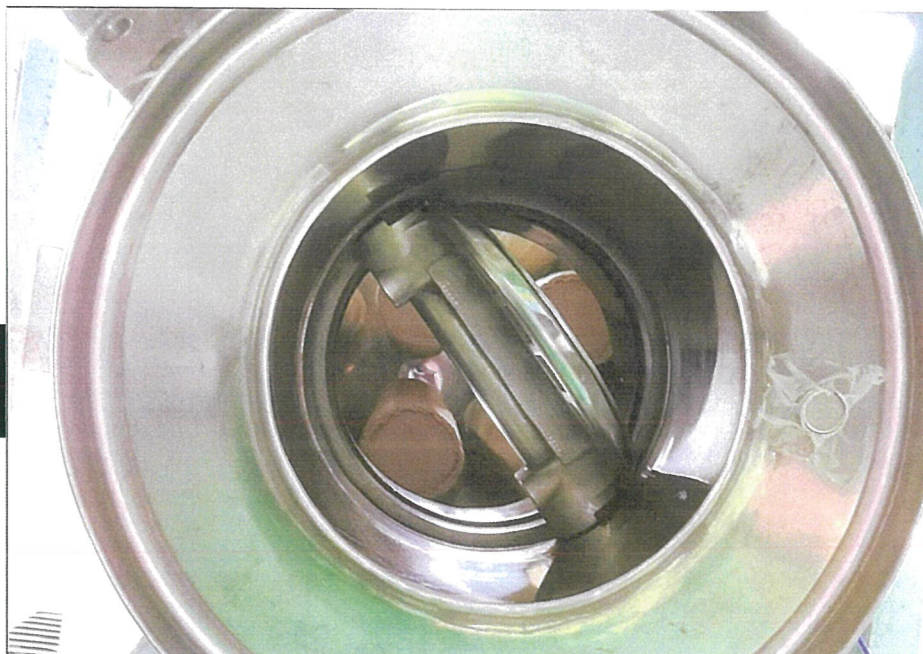
バグフィルタ下部を、バグフィルタ弁を立てて開いた状態で裏面から撮影（写真右側が測定箇所G）。
