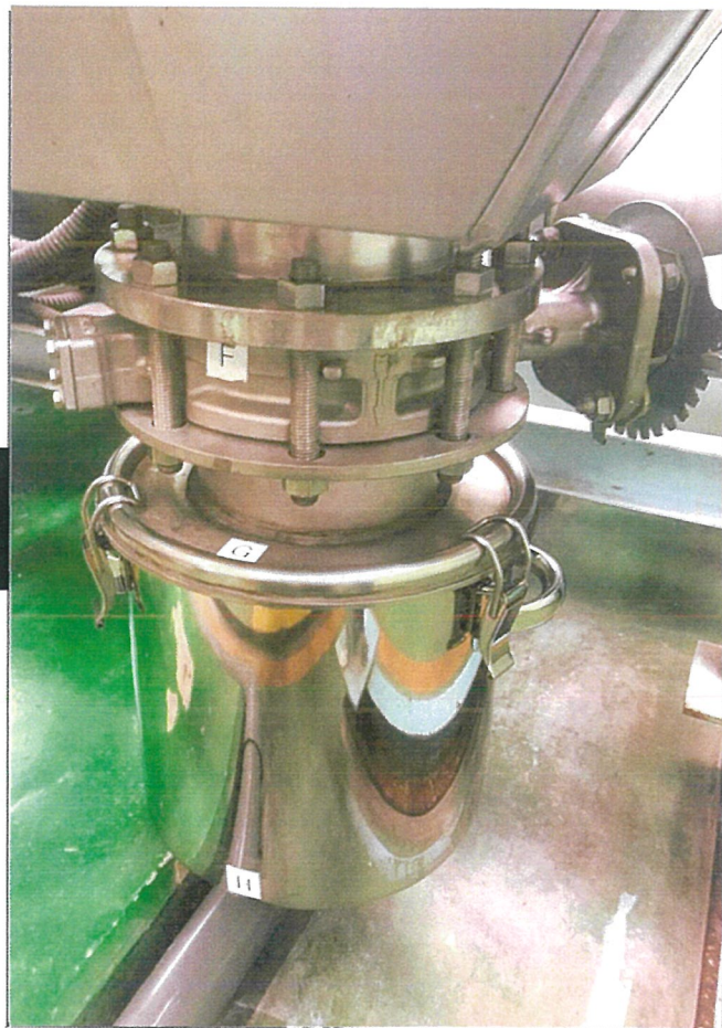
バグフィルタ下部およびポット外観を撮影。
