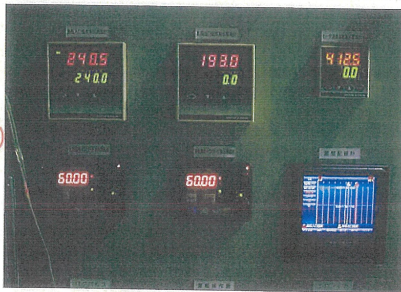
前葉時刻の熱風入口温度表示調節計、排風出口温度表示警報計を撮影
