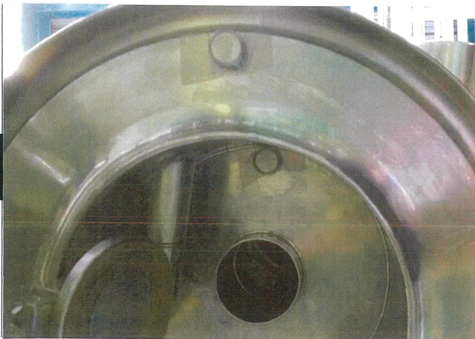
サイクロン下部を裏側から撮影。
