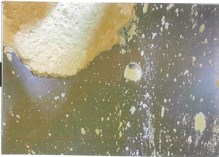
乾熱運転直後の乾燥室測定口（測定箇所A）を乾燥室内部側から撮影。
