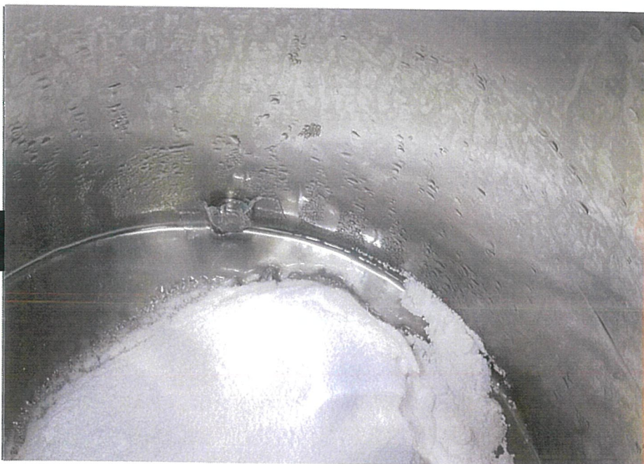
乾熱運転直後のバグフィルタポット内部（測定箇所 H）を撮影。
