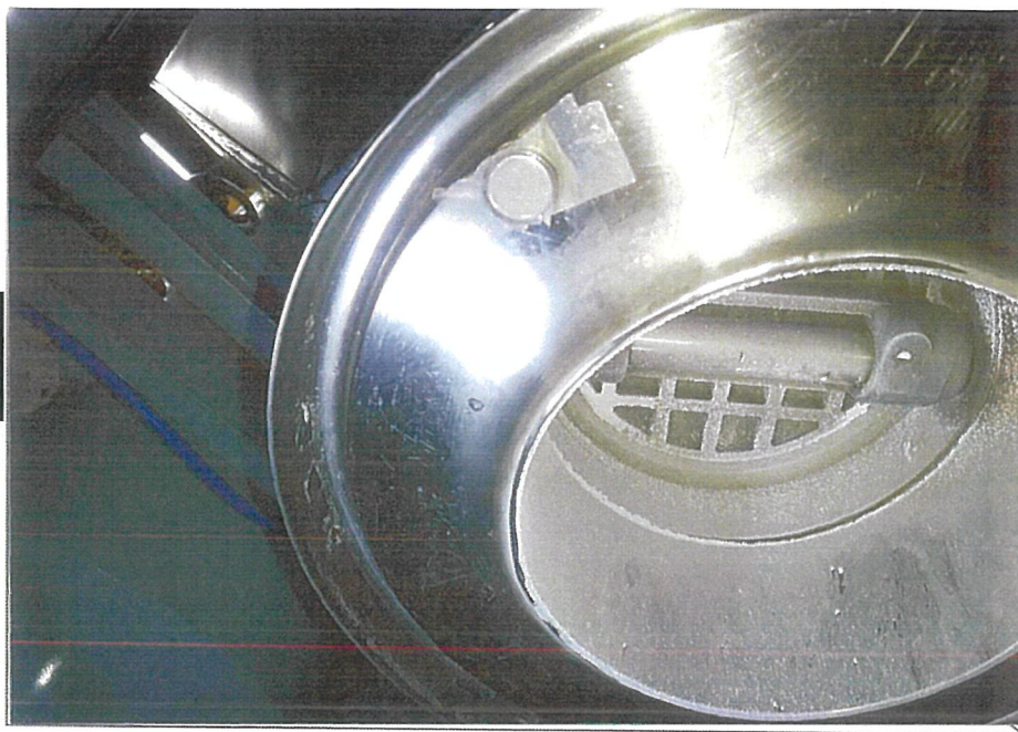
乾熱運転直後のバグフィルタ下部（測定箇所 G）を裏側から撮影。
