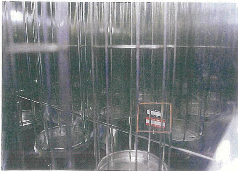
温度測定箇所⑦の「バグフィルタ中間（奥）」に2種類のサーモラベルを貼付した状況を撮影。
