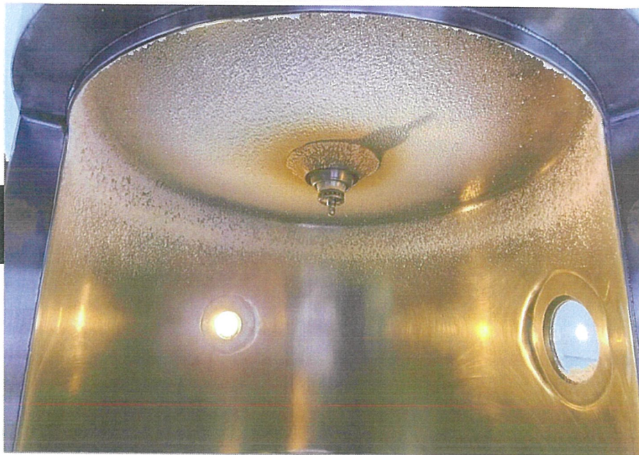
乾熱運転直後の乾燥室上部を撮影。
