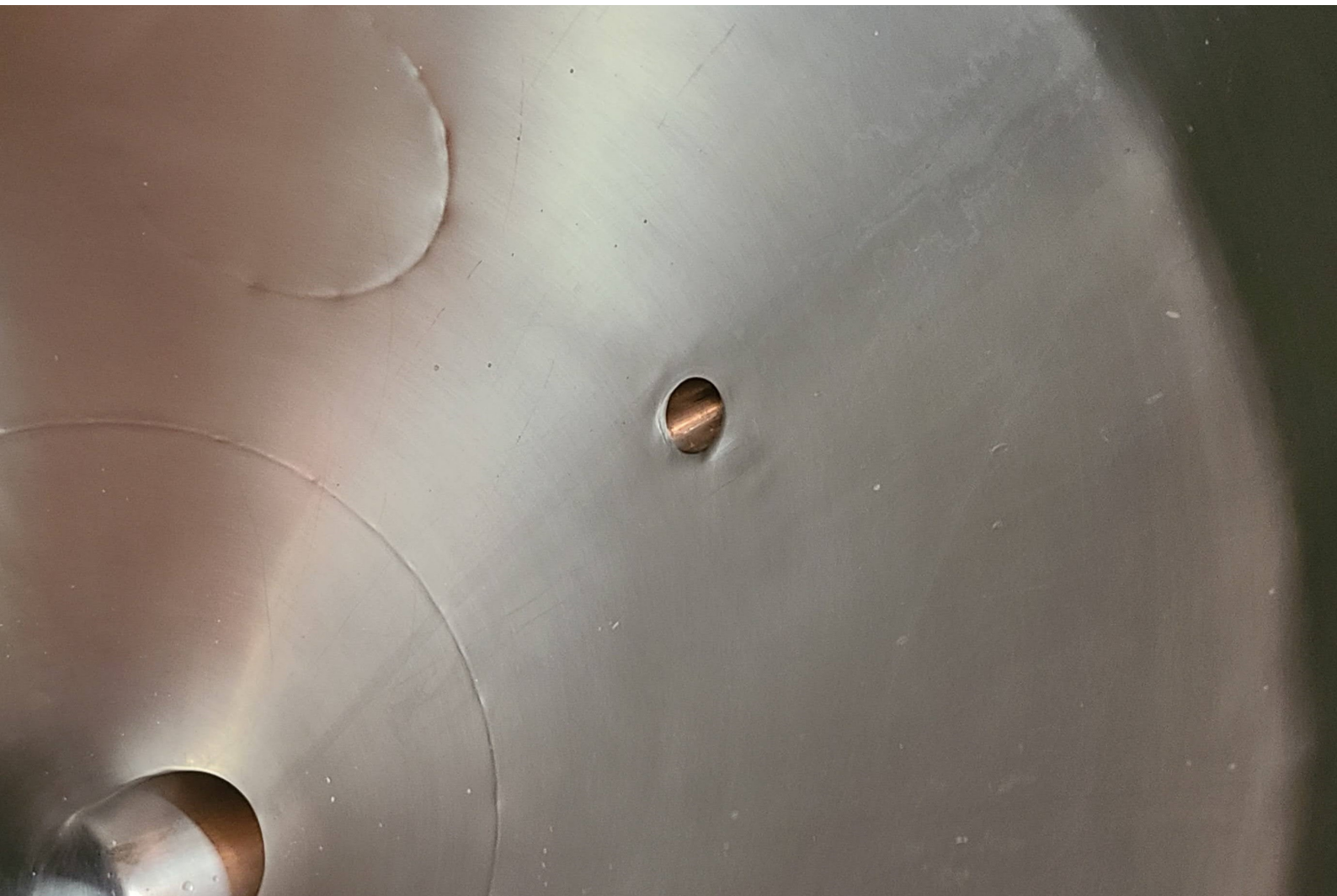
本件噴霧乾燥器 1 の乾燥室測定口を乾燥室内部から撮影したもの（乾燥室測定口は写真中央）
