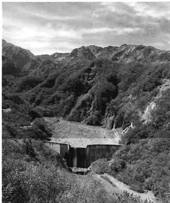
写真 2.2.1 女峰山と日向砂防堰堤の堆積土砂
