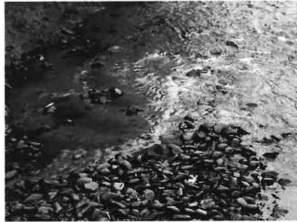
写真 3.3.5 旧田川十二天橋の直上流の河床の様子 (洪積粘性土層の露出) (2008年4月)
