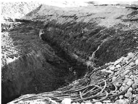
写真 3.3.4 55.25km 左岸の河床の様子 (護岸工事により露出した洪積礫層) (2008年1月)
