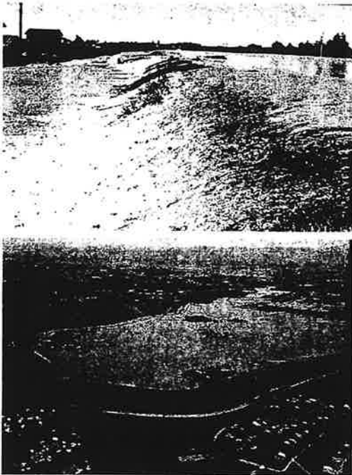
写真-3 昭和61年小貝川での越水による氾濫 〔この越水が生じた区間では堤防は決壊していない〕
