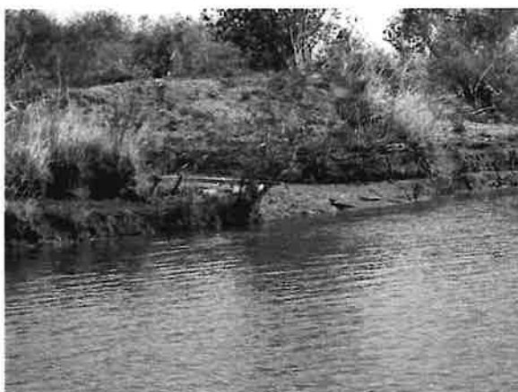
写真 3.3.6 22.5km 左岸の河床の様子 (沖積粘性土層とその上部の浮遊堆積物) (2008年4月)
