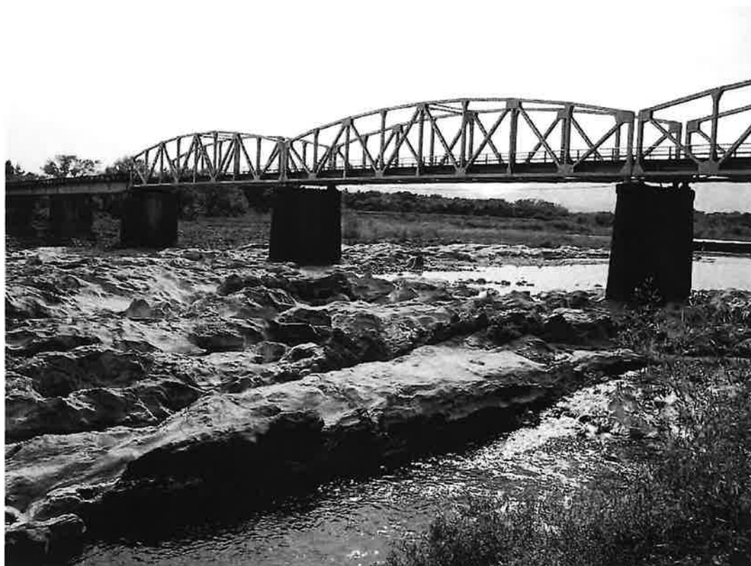
写真 3.1.1 観音橋下流の凝灰岩質泥岩 (2005年5月)
