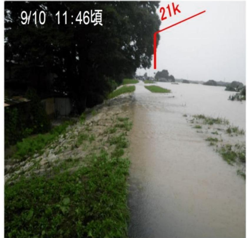
②越水時川裏法面状況
