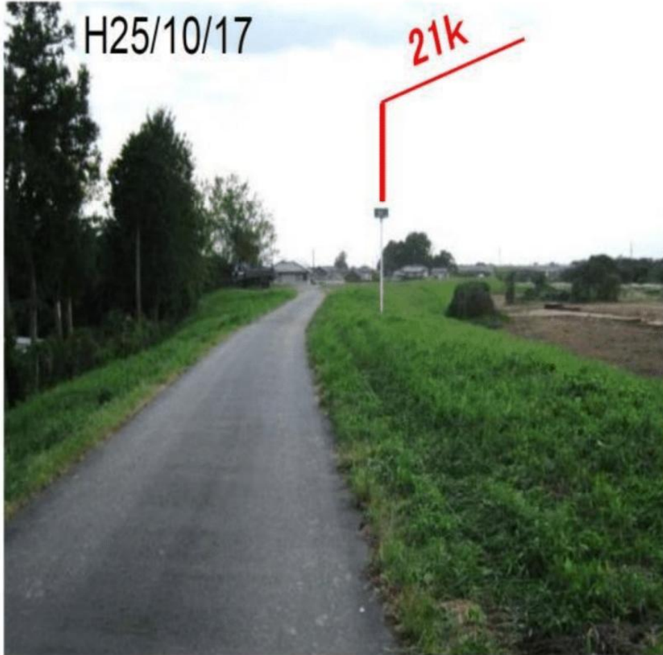
①被災前堤防天端状況
