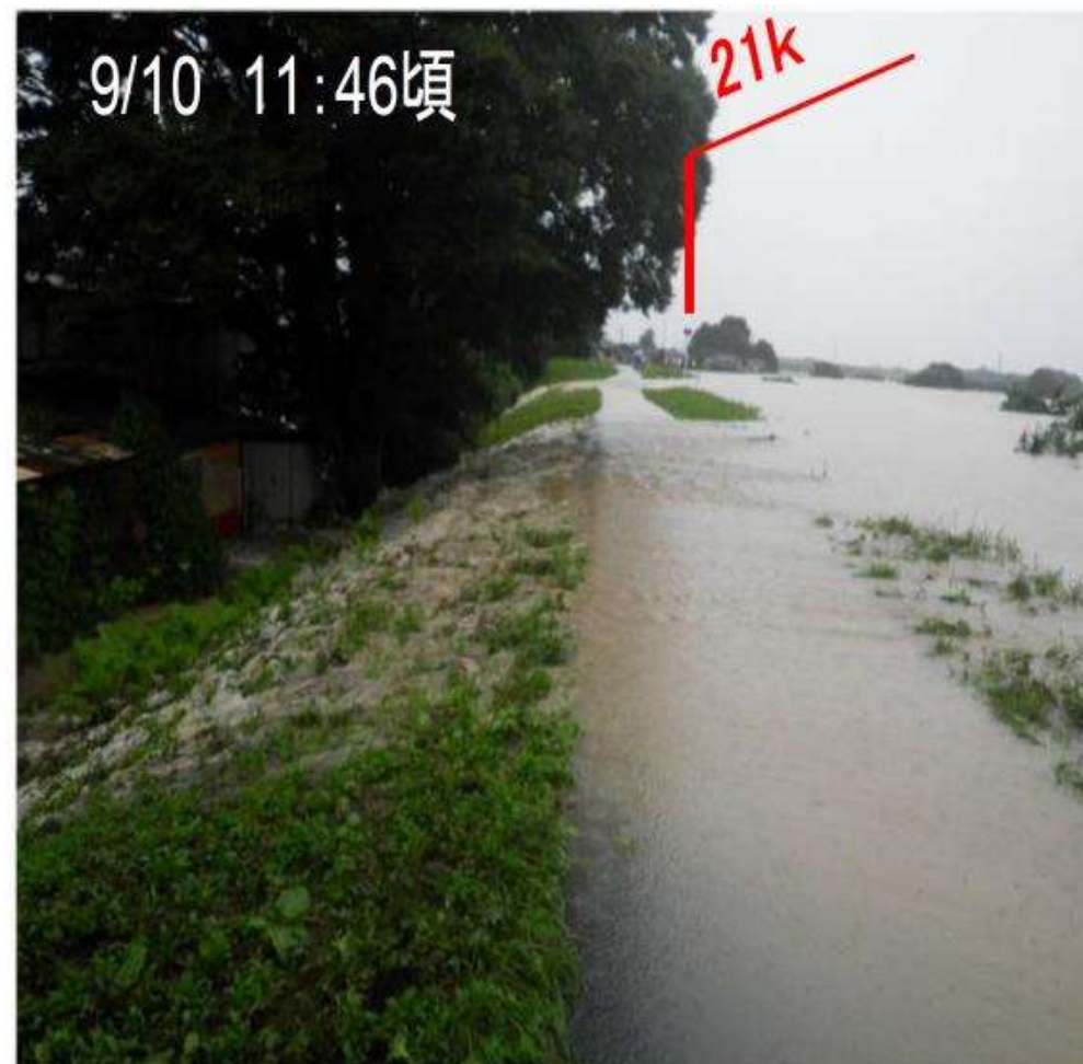
②越水時川裏法面状況
