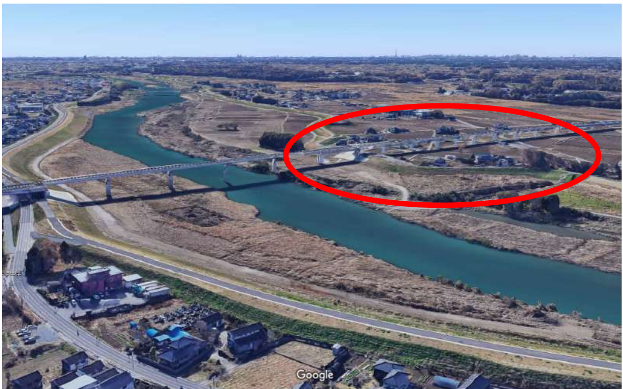
圏央道鬼怒川橋梁 鬼怒川左岸上流側から
