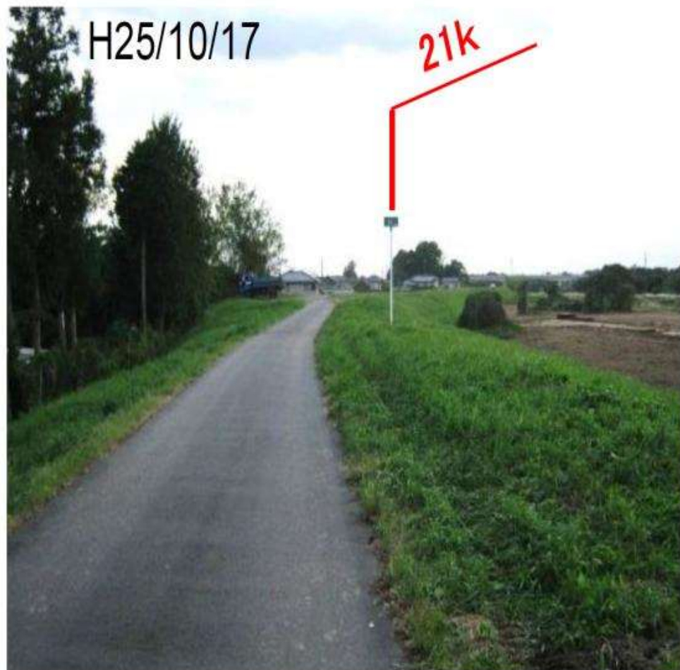
①被災前堤防天端状況
