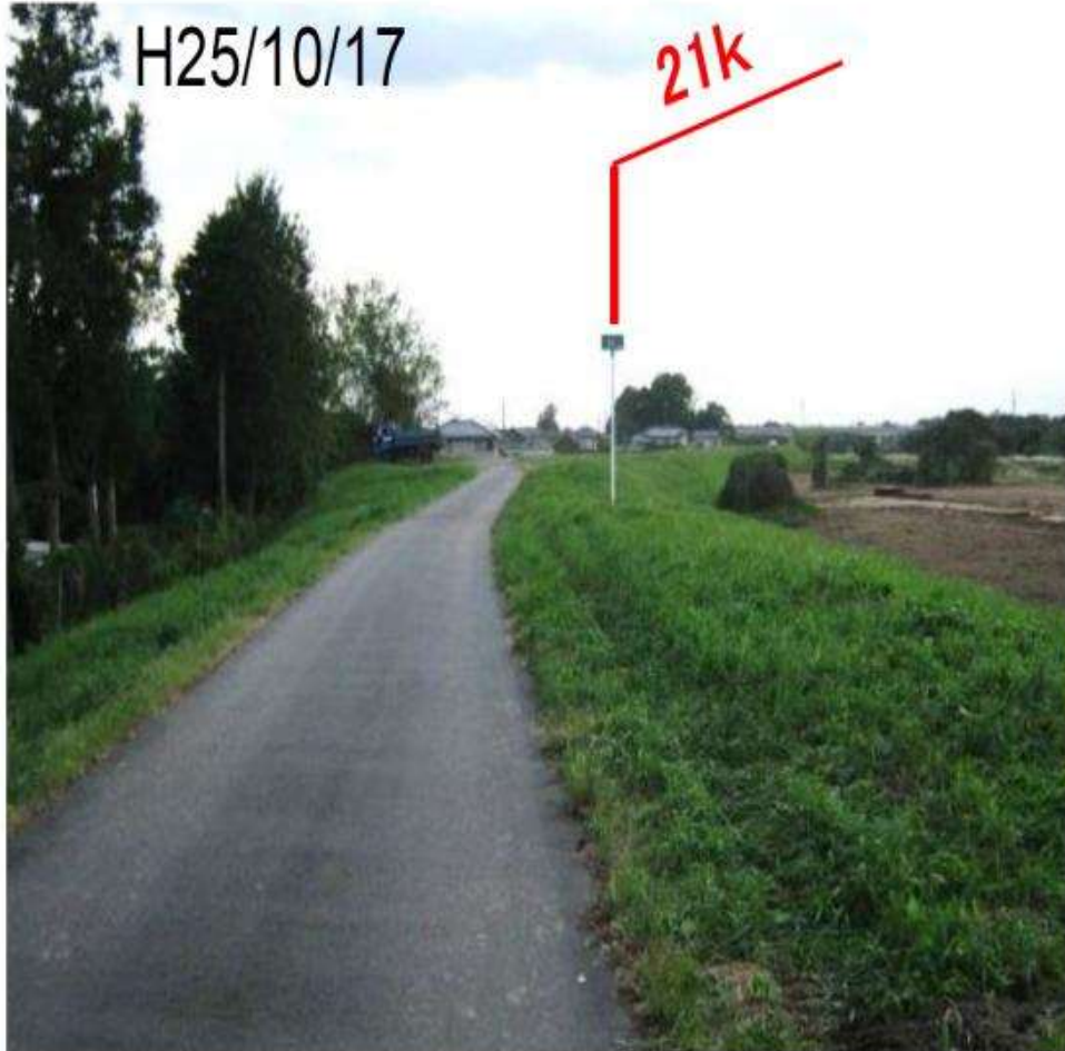
①被災前堤防天端状況
