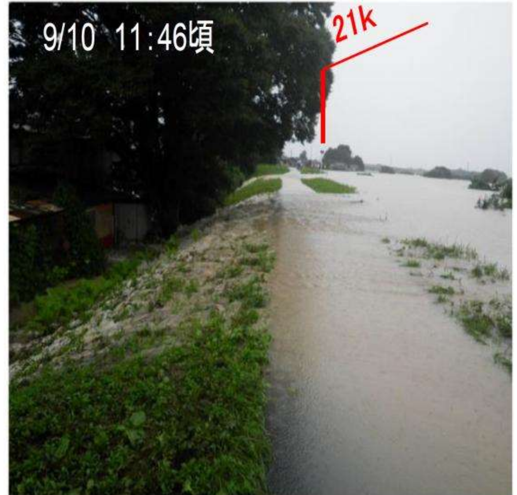
②越水時川裏法面状況
