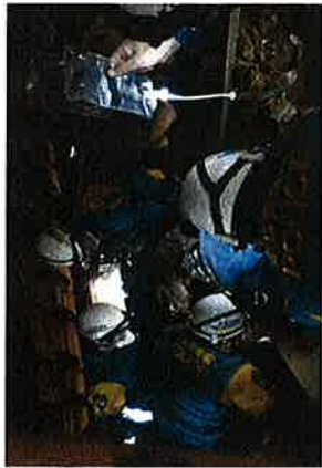
倒壊建物内からの救出活動（4月、熊本）
